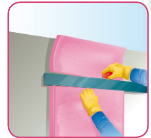
Corte el material excedente con una navaja o cuchillo con filo.
