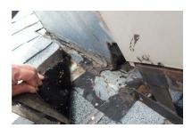
Revise los flashing Revise los flashing y asegúrese que no estén oxidados, rotos o el sellador deteriorado.
