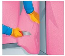
7.- El aislamiento al instalarse debe ser protegido con un material aprobado como paneles de yeso. En climas templados donde raramente se tienen temperaturas bajo 0°C, no se necesita una barrera de vapor.
